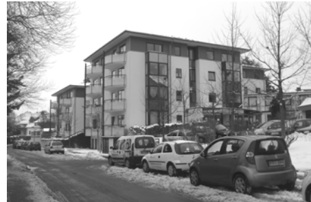
und Haus am Stiftsheim Firnsbachstraße 6
