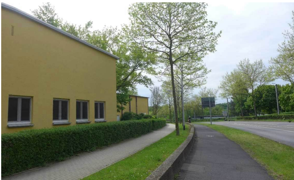
Straßenansicht des Planbereiches an der Eugen-Richter-Straße (von Norden) | AG Stadt
