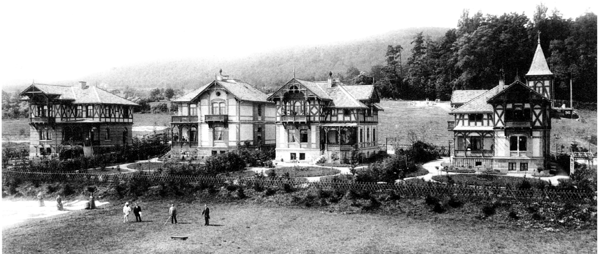
Wohnen im Mulang Kassel Bad-Wilhelmshöhe Entwicklung Areal Burgfeldkrankenhaus
