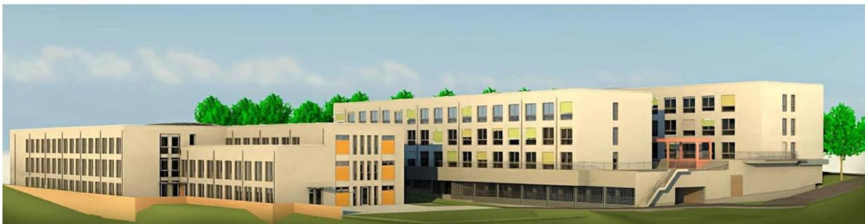
Beide Gebäudegruppen will das Land in innovativer Bauweise als reine Holzbauten jeweils mit 3 Geschossen und Höhen zwischen 10 bis 12 m errichten. Für die Bauten sind Putzfassade versehen da mit dem direkt angrenzenden Waldgebiet Holzfassaden an diesem Standort aufgrund von Vermoosung und Verwitterung eher ungeeignet sind. Auf allen Gebäuden sind, auch zur Minderung der Eingriffswirkung, extensiv begrünte Flachdächer vorgesehen.
