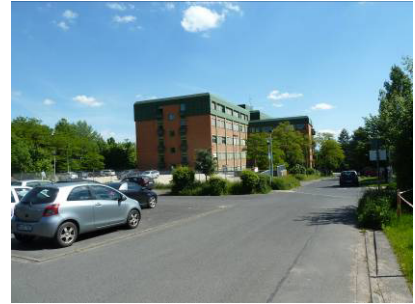
Nördlich gelegener Privatparkplatz mit Landesbetrieb Hessisches Landeslabor
