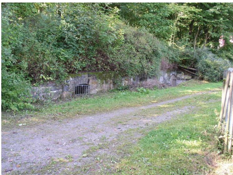
Eiskeller unterhalb der Alten Post
