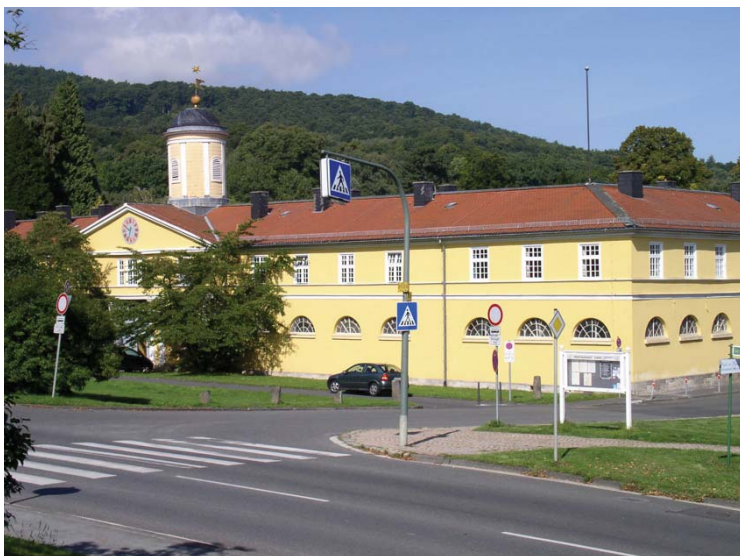
Vorplatz, Blick auf Marstall
