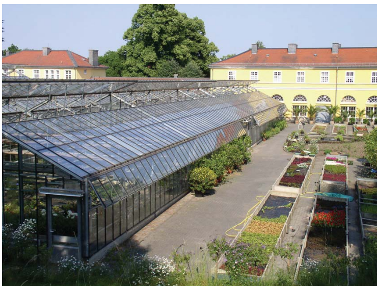
Gewächshäuser MHK, Marstall im Hintergrund
