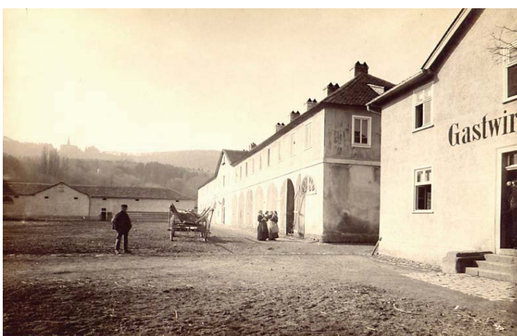
Südliche Remise, rechts Ausweichgaststätte, ca. 1890
