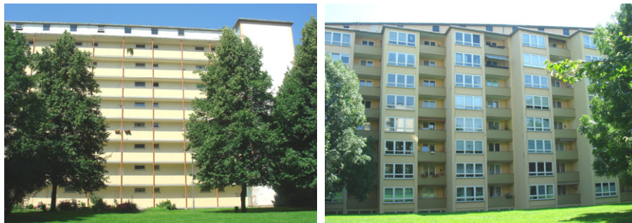
Ansichten der Hochhäuser Friedrich-Ebert-Straße 67 und 69
