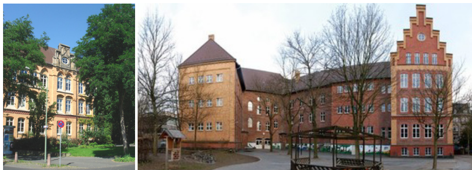
Straßenansicht von Osten
