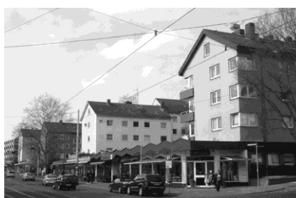
die kammartige Baustruktur gegenüber (heute)
