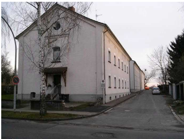
Westlich angrenzende Wohnbebauung (Denkmalensemble) von Theodor-Fliedner-Straße
