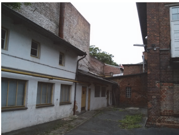
Abb. 8: Anbauten und Brandwand auf Nachbargrundstück südlich des denkmalgeschützten Riegels
