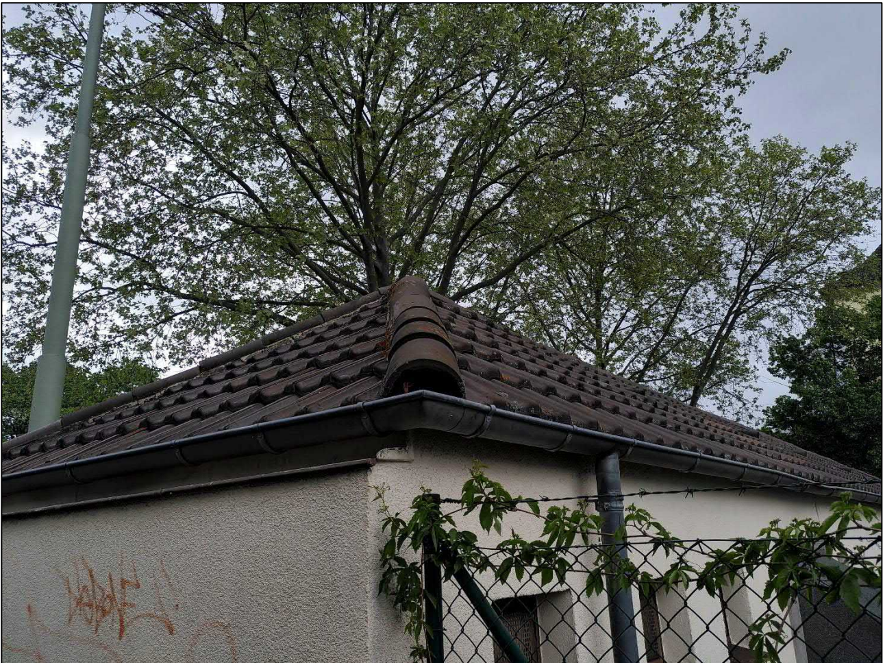
Abbildung 3: Eckziegel mit Zugangsmöglichkeiten
