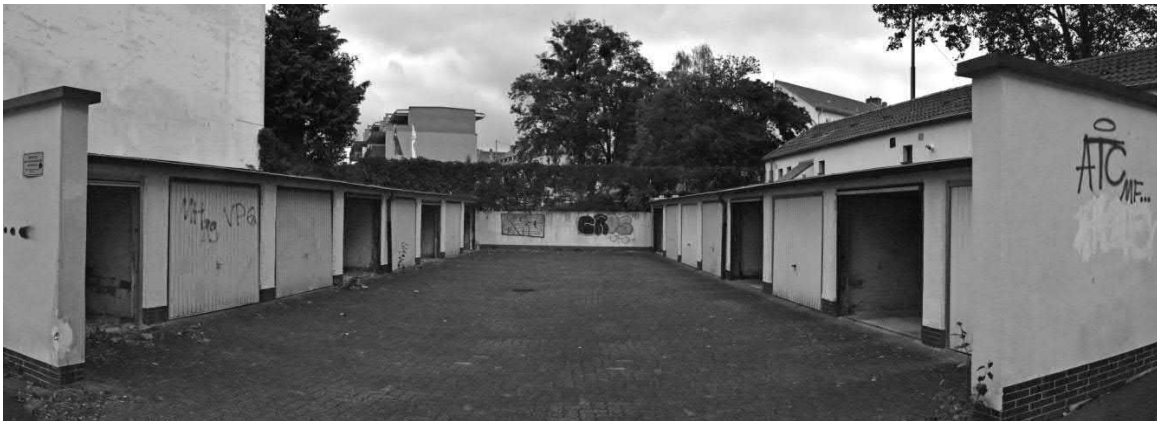
Abb. 1: Eingefriedeter Garagenkomplex, Blickrichtung Nordwesten
