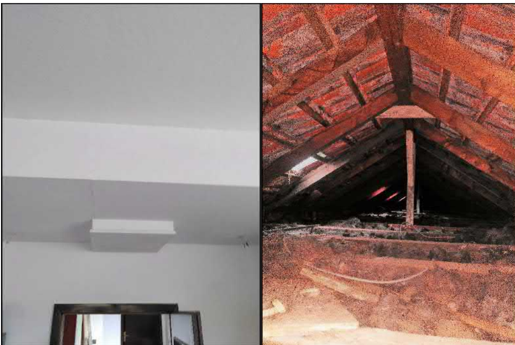
Abbildung 5: Links: Zugang Dachstuhl; Rechts: Blick in den Dachstuhlbereich
