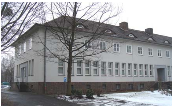
Gebäude der ehemaligen Landesfeuerwehrschiele Ansicht Ortelsburger Strasse
