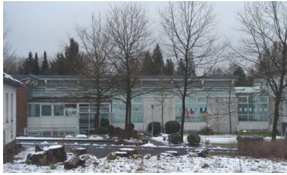
Erweiterungsbau aus den 80er Jahren des 20. Jhrds.
