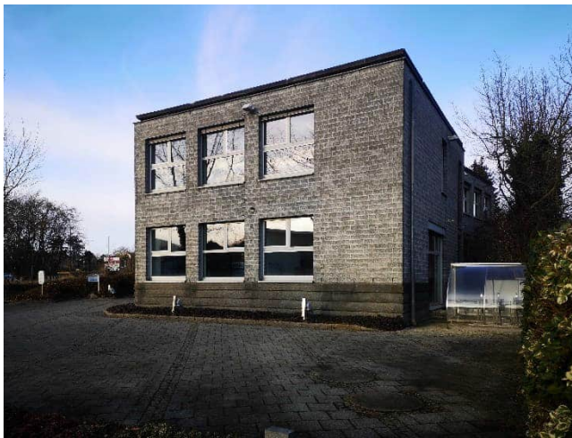
Abb. 9: Ansicht Bestandsgebäude Richtung Westen
