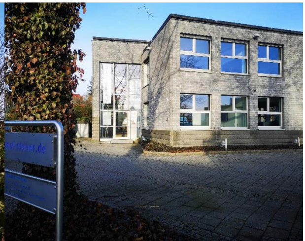
Abb. 10: Ansicht Bestandsgebäude Von der Harleshäuser Straße Richtung Norden
