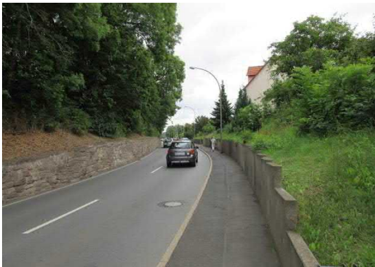
Obervellmarer Straße mit beidseitigen Mauern
