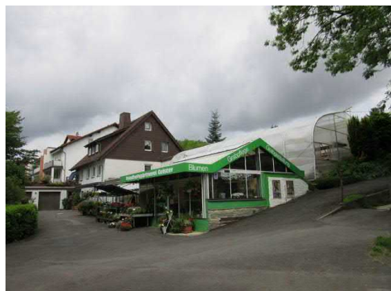
Ladenlokal und Wohnhaus der Gärtnerei am Südende
