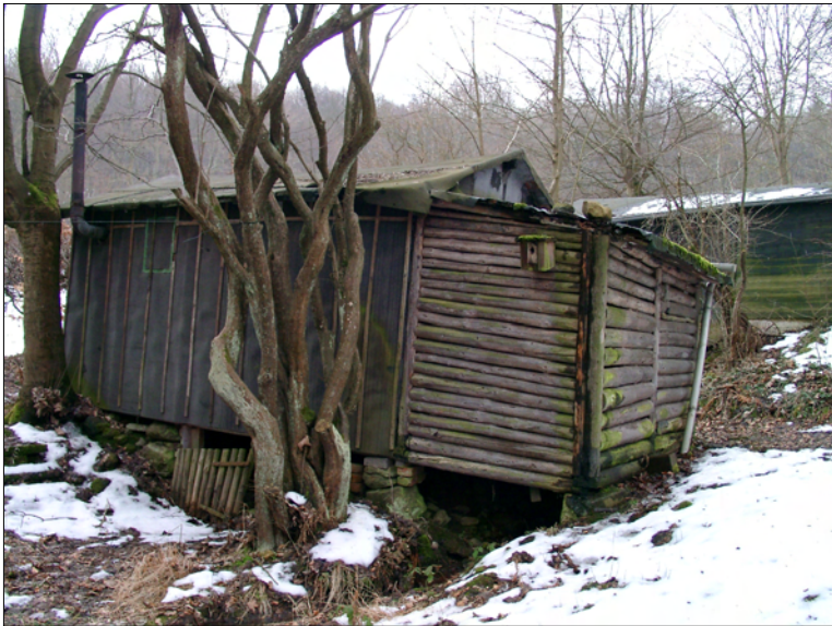
Laube mit Anbau über dem Bachlauf, links Abgasrohr
