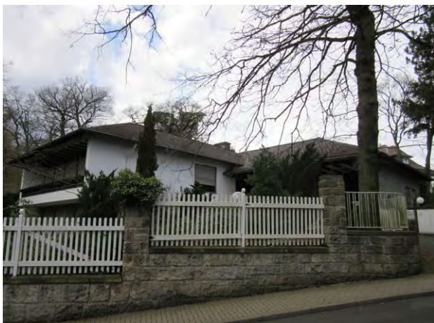
Ansicht von der Klinikstraße
