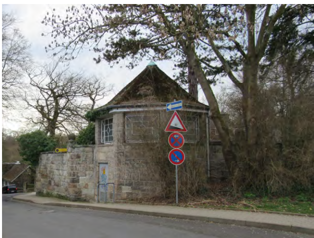
Pavillion an Nordostecke
