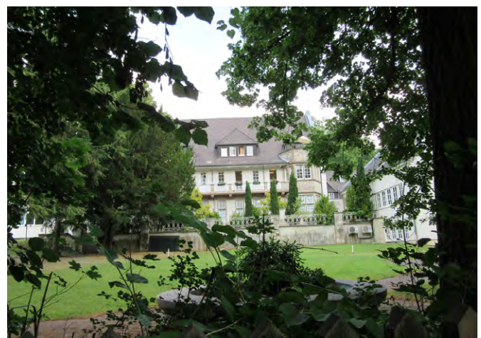
Ansicht von Süden über den Zaun durch die dichte Bepflanzung
