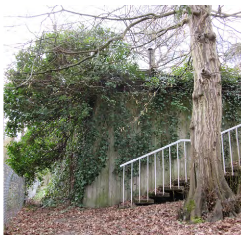
Betonmauer zur Geländeabfangung im Süden
