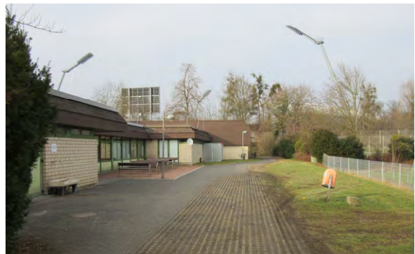
Bereich vor zukünftigem Halleneingang
