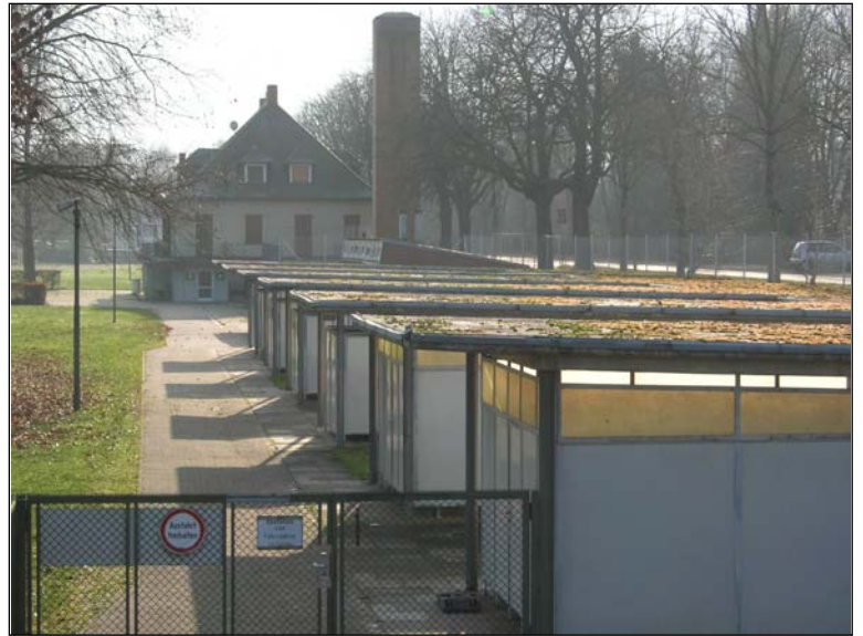
Umkleidekabinen, im Hintergrund Heizzentrale und Empfangsgebäude
