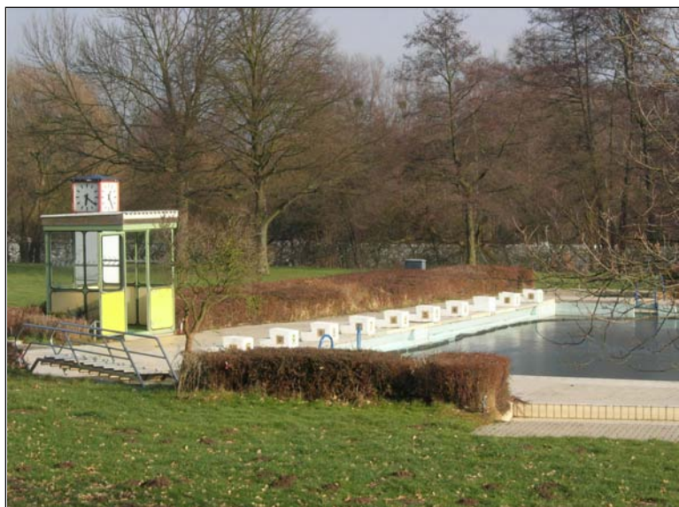
Schwimmerbecken, Kabine Badeaufsicht
