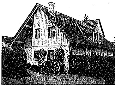
Wohnhaus für Betriebsangehörige Georg-Fladung-Str. 2
