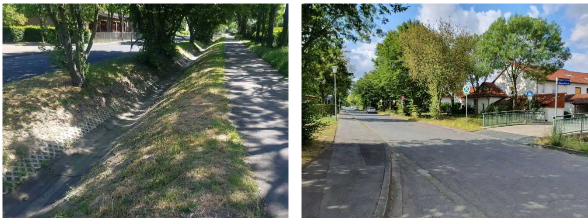
Abb. 5: Naturferner Wälzebach (Blickrichtung Süden) sowie Stegerwaldstraße mit Brückenbauwerk (Blickrichtung Süden)
