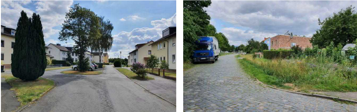
Abb. 4: Anger Stegerwaldstraße (Blickrichtung Osten) sowie Kasseler Straße mit rückwärtiger Bebauung (Blickrichtung Westen)
