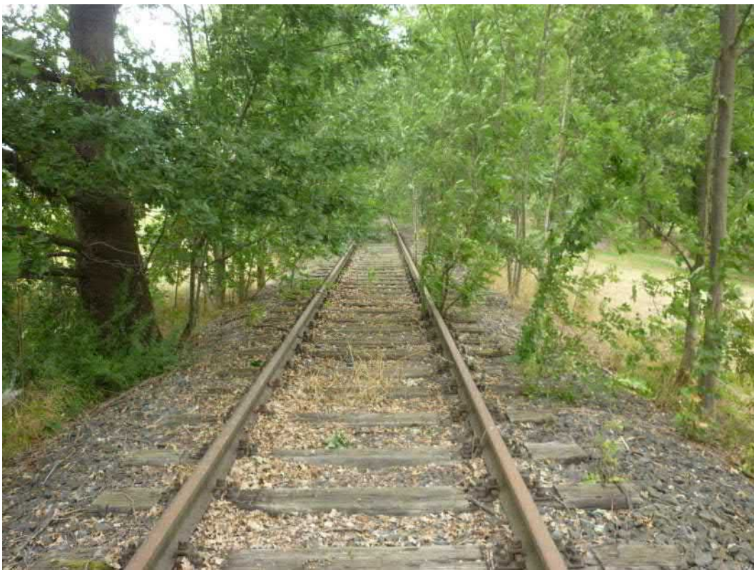
Abbildung 5: Blick aus Richtung Osten entlang des Gleiskörpers (Flurstücksnummer 35/1).
