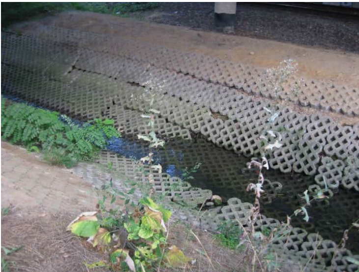
Abb. 29: Gewässerunterführung Gobietstraße (Quelle: Umwelt- und Gartenamt; Umweltplanung)
