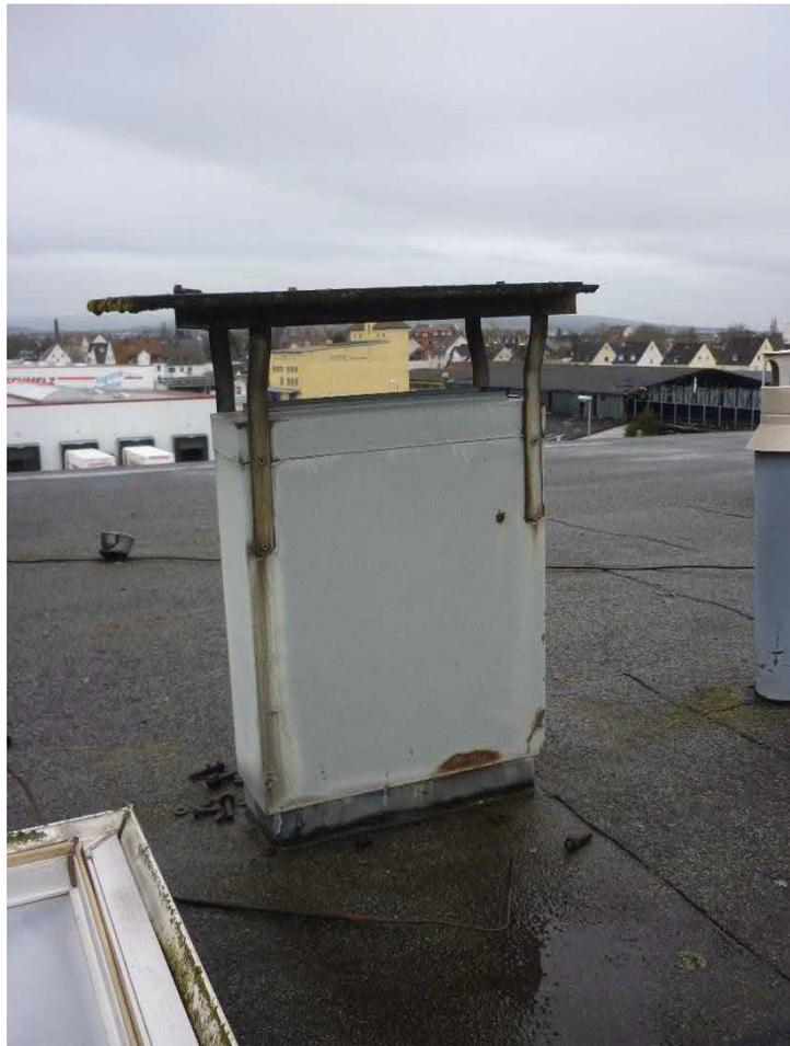
Abbildung 8: Lüftungsschacht auf dem Flachdach des Hotels.
