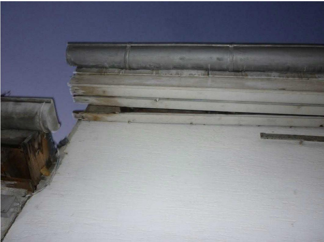
Abbildung 21: Weitere defekte Holzverkleidung am Garagengebäude. Potentieller Ausflugsbereich.
