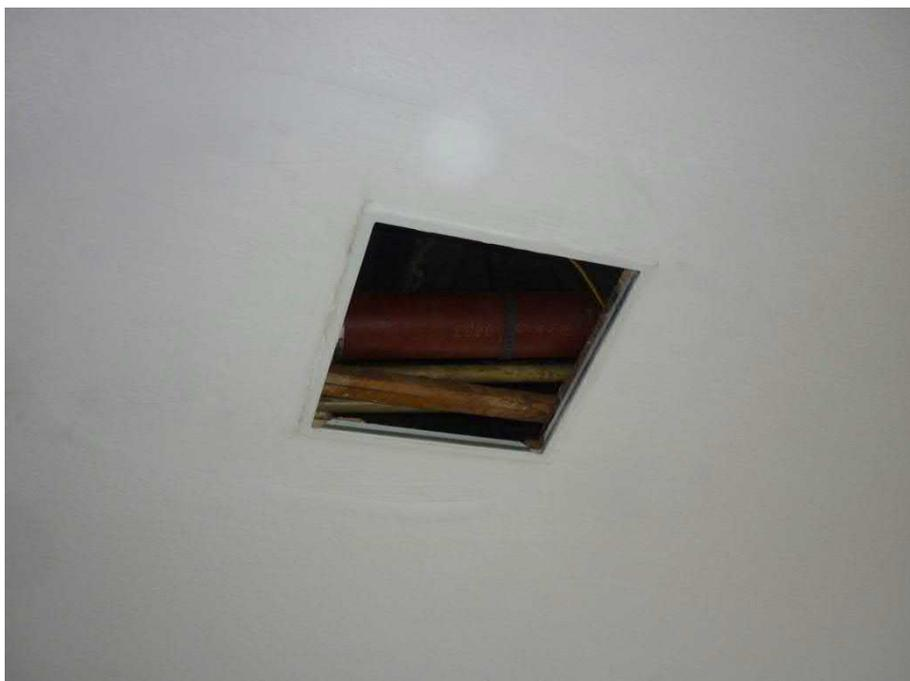
Abbildung 3: Offener Kabelschacht an der Decke des Anbaus.
