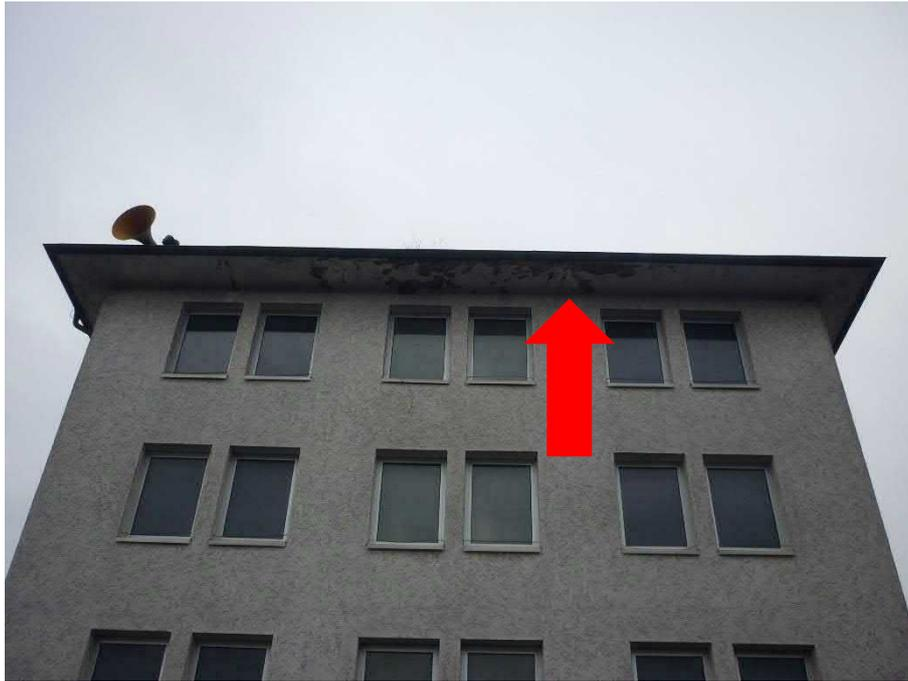
Abbildung 15: Blick auf die Fassade des alten Hotelgebäudes. Der rote Pfeil zeigt auf den Spalt zwischen Flachdach und Isolierung, der sich rund um das Gebäude zieht.
