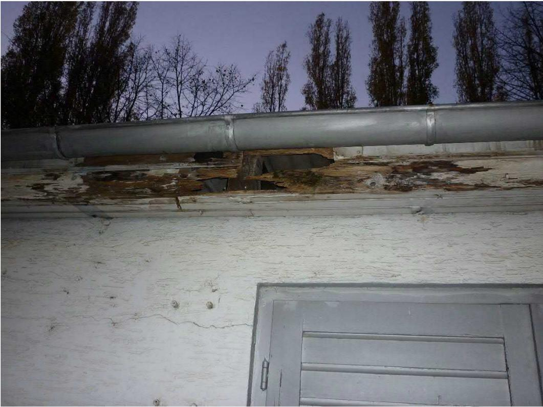
Abbildung 20: Defekte Holzverkleidung am Garagengebäude. Potentieller Ausflugsbereich.
