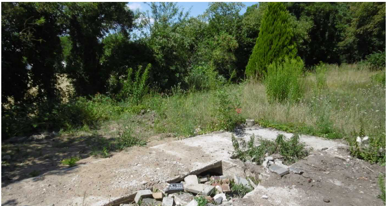
Fundamente einer ehemaligen Gartenlaube
